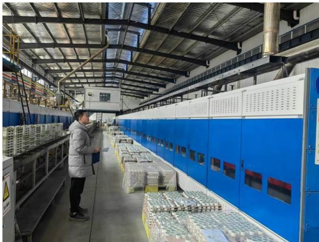
推板窑（工程师现场踏勘）
